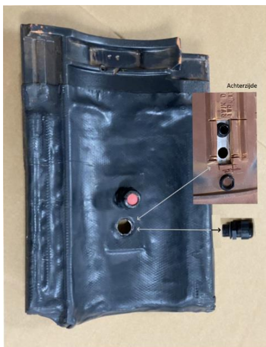
Figuren 13 - Samenstelling dakdoorvoer
