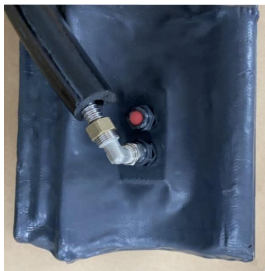
Figuur 23 – Dakdoorvoer gemonteerd. Voor aanbrengen Aerotape
