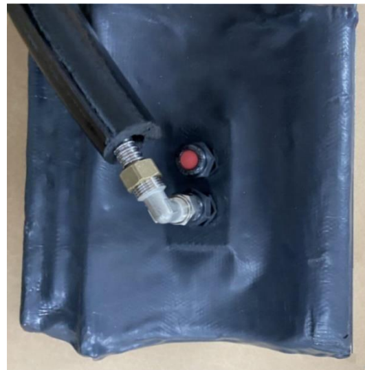
Dakdoorvoer gemonteerd. Voor aanbrengen Aerotape
