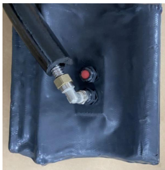
Dakdoorvoer gemonteerd. Voor aanbrengen Aerotape
