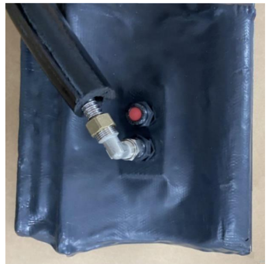
Dakdoorvoer gemonteerd. Voor aanbrengen Aerotape
