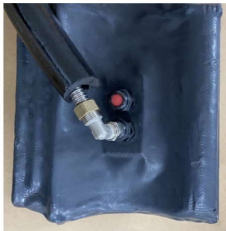
Dakdoorvoer gemonteerd. Voor aanbrengen Aerotape
